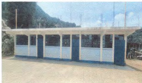
Foto 13: 19.2 Fabricación he instalación de balcones de hierro en ventana
