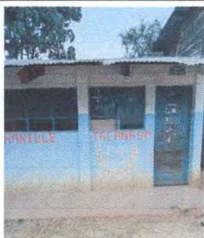
Foto 3: 5.6. Sustitución de vidrios
