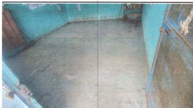
Foto 4: 6.1 Reparación de piso de torta de concreto
