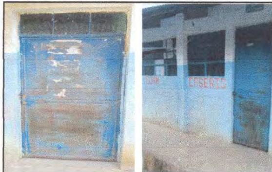
Foto1: 4.1 Mantenimiento a estructura (Aplicación de pintura)
