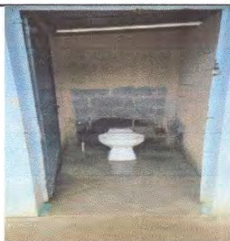
Foto 11: 14.3 Sustitución de tubería PVC Línea principal aguas negras
