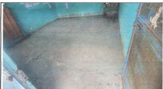
Foto 5: 6.8 Sustitución de piso ceramico
